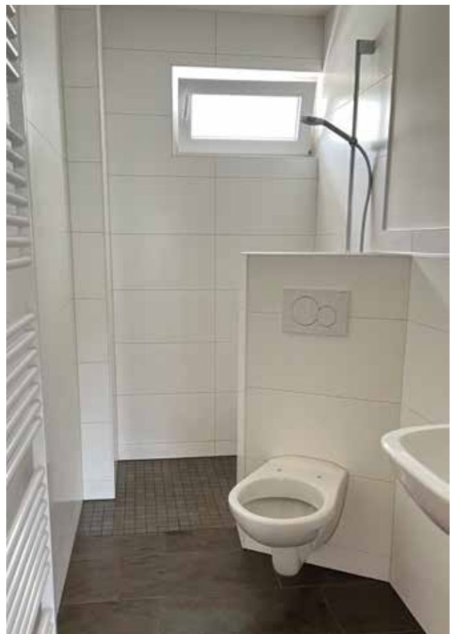
Bad in der Lönsstraße
