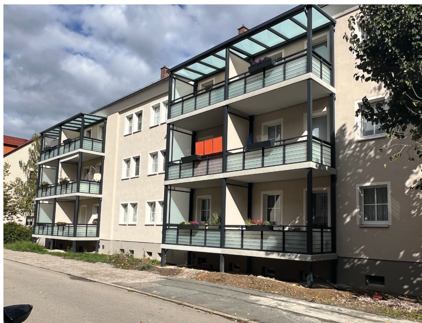
Neue Balkone am Gebäude Thomas-Müntzer-Straße 4–6.
