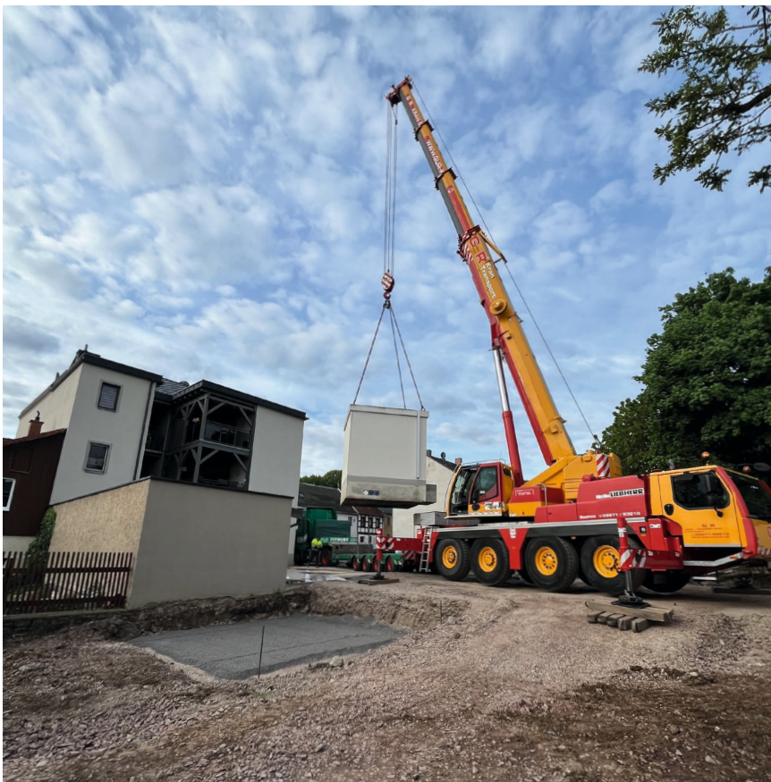
Installation einer neuen Trafostation.
