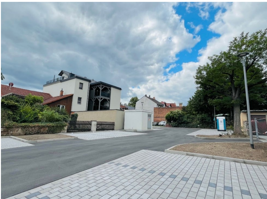
Fertiggestellter Parkplatz mit Trafostation
