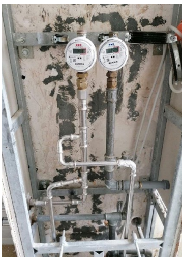
Strangsanie rung Stauffenbergstraße 72–84
