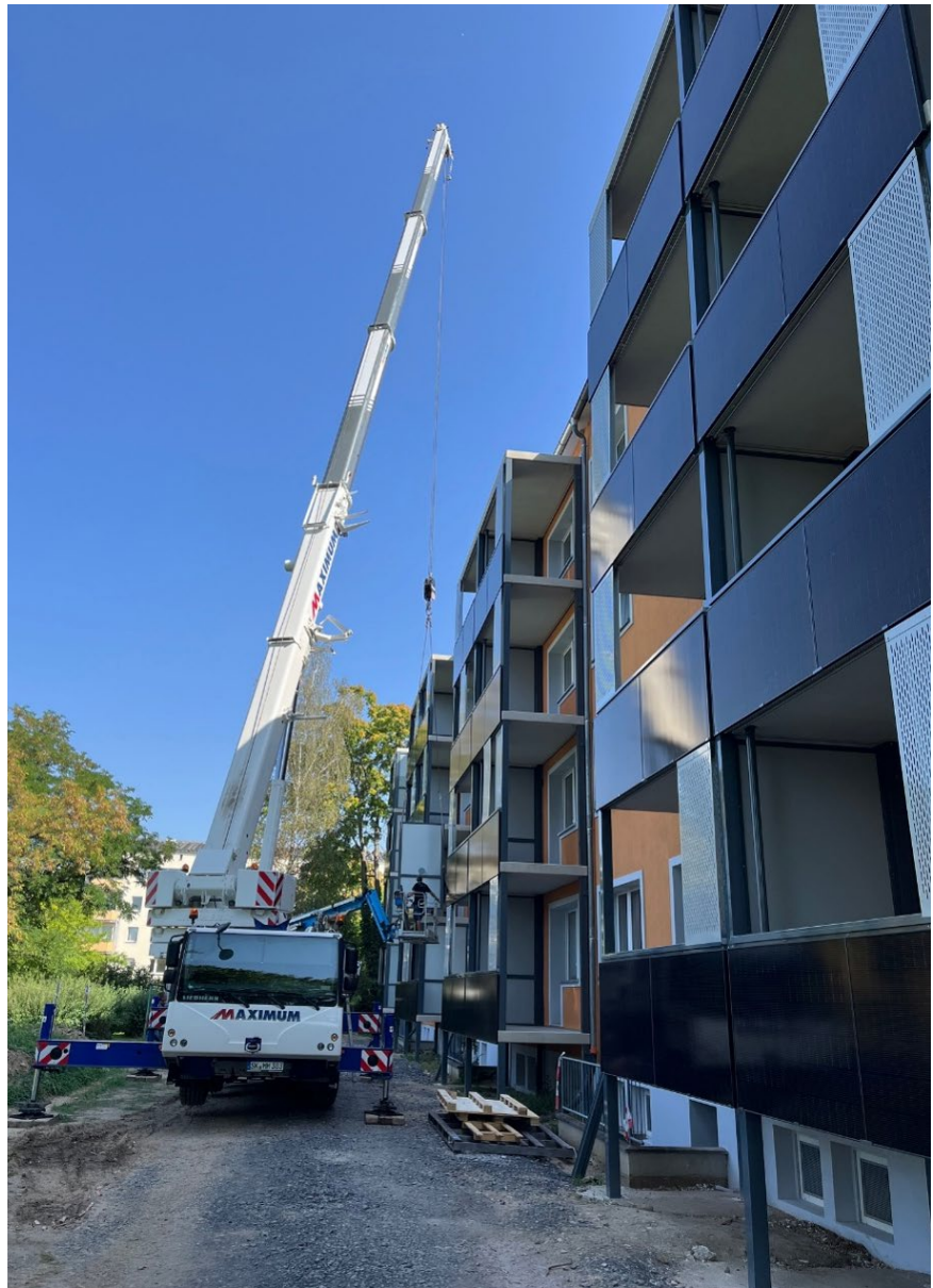
Montage der Balkonelemente
