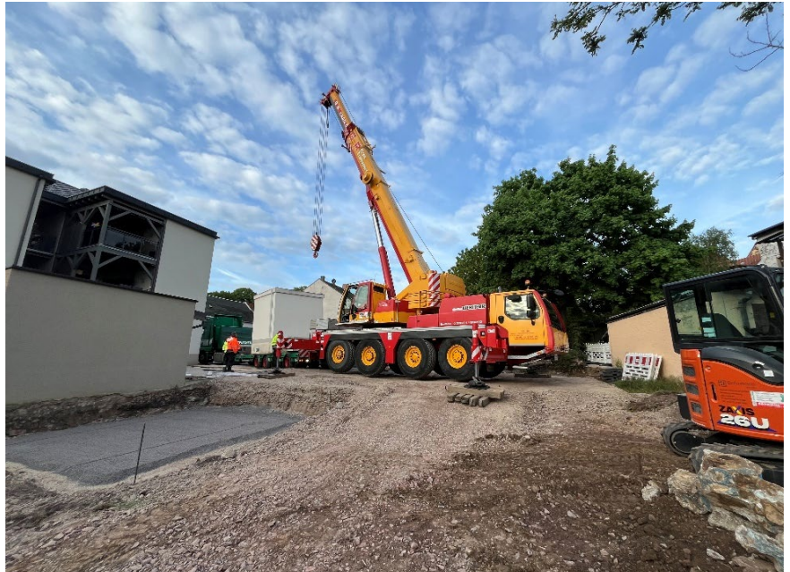
Installation der neuen Trafostation
