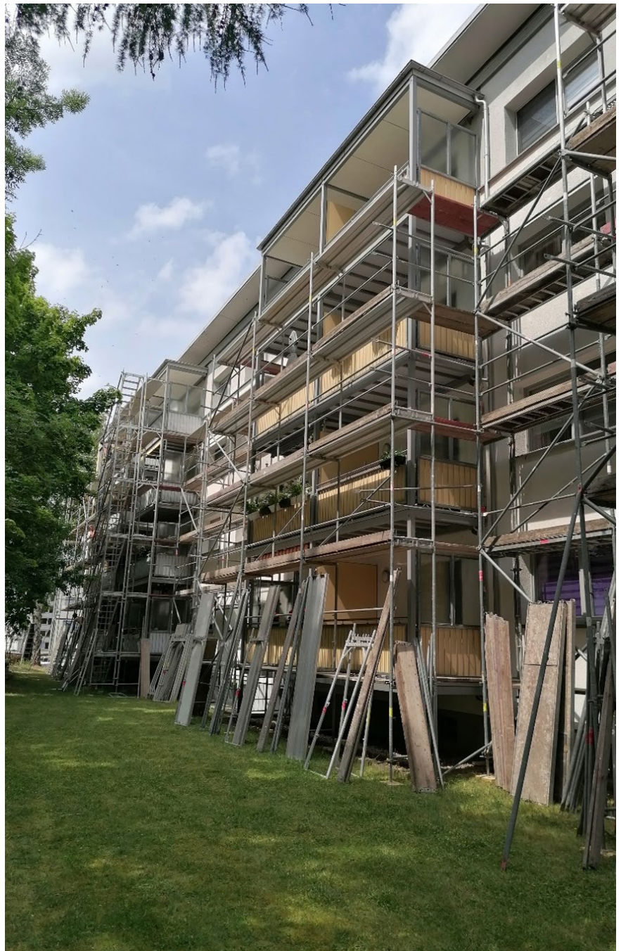
Fassadenarbeiten Am Bernhardsgraben 34-38 und 42-46
