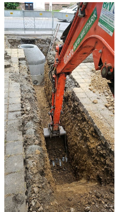
Grundleitungserneuerung in der Thomas-Müntzer-Straße 4–6 und 8–10
