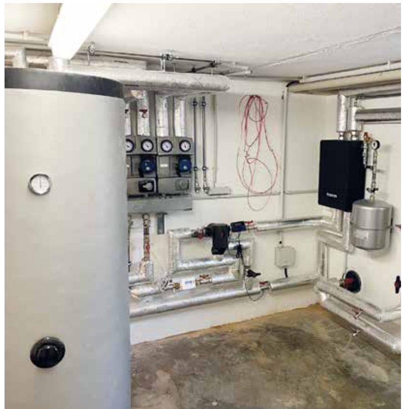
Grobstraße 44-46, Einbau einer Gashybridheizung
