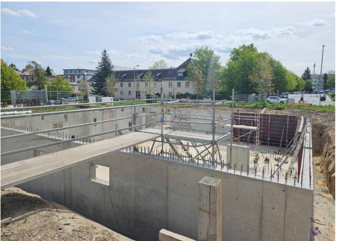
Errichtung des Kellergeschoßes im ersten Haus
